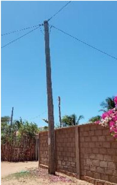
Exemple poteau en bois à remplacer par un poteau en béton à Toliara
