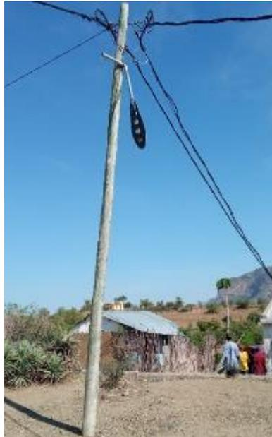
Poteau en bois BT à remplacer par un poteau en béton MT pour emplacement d'un nouveau poste à Benenitra
