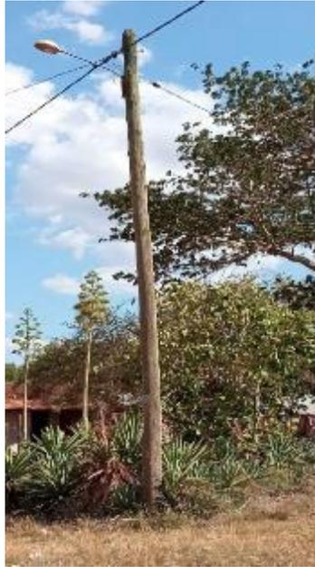
Poteau BT en bois à remplacer par un poteau MT en béton pour l'emplacement du nouveau poste
