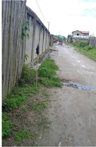
Exemple site d'implantation de nouveau poteau en béton à Arivonimamo
