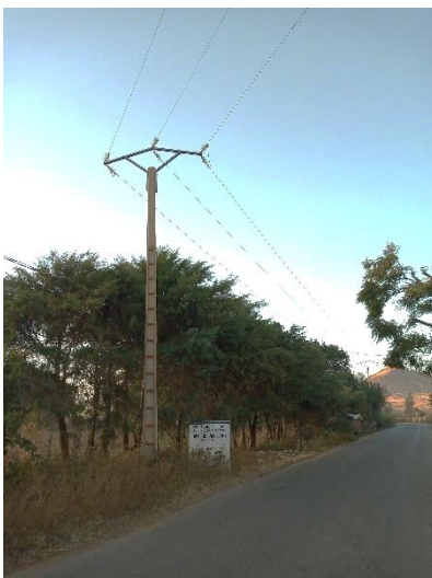
Raccordement nouvelle ligne MT
