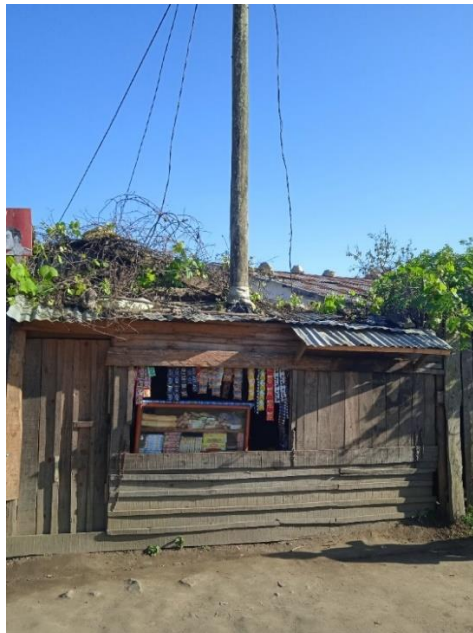
PHOTO 12 : CASE EN BOIS A DEMOLIR (MORAMANGA)
